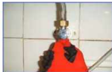
الف- بستن شیرهای آب گرم و سرد بیسوار زیر کاسه
