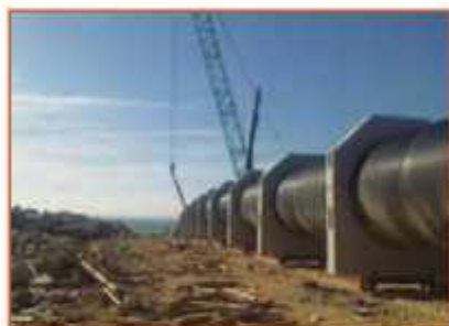
ت - احداث خطوط لوله
