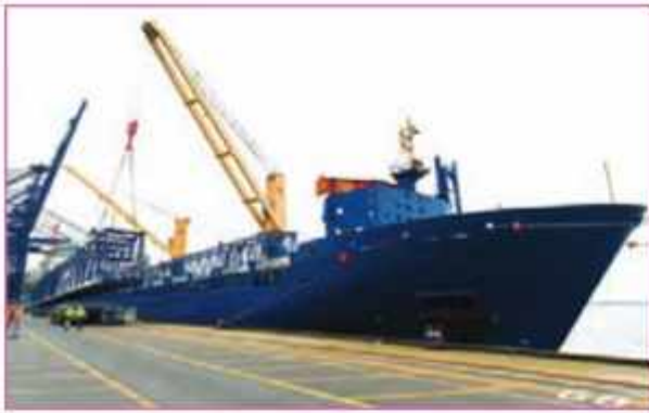
الف - نصب جرثقیل بر روی کشتی
