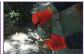
ب - باز کردن کلگی شیر با آچار در جهت خلاف حرکت ساعتگرد
