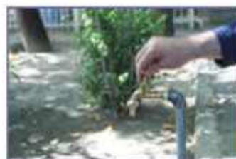
خ - آزمایش آب بندی شیر
