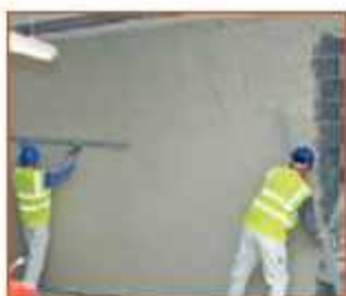
ب - آندودکاری دیوار با گچ
