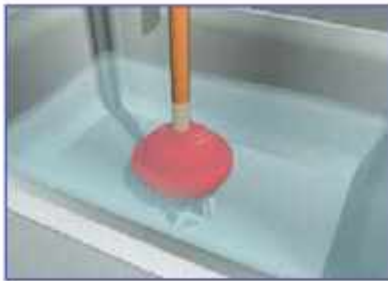
الف - جمع شدن آب روی زیراب
