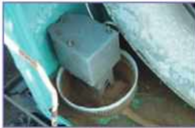
ج- بررسی و تمیز کردن بلمب آب
