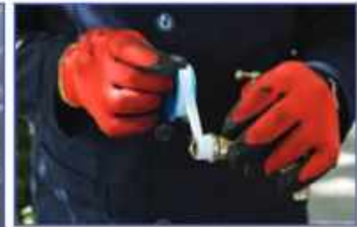
ب- ببیندن نوار تفلون روی شیر نو
