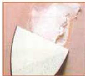
ب - لکه گیری و ترمیم ترک‌ها
