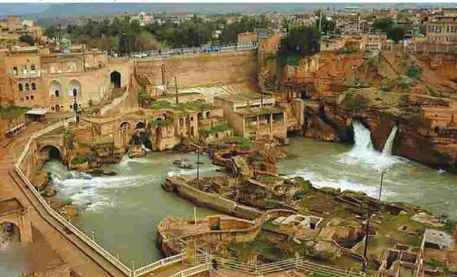
شکل ۳-سازه های آبی-تاریخی، شوشتر، خوزستان
