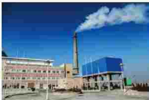
اولین نیروگاه زباله‌سوز تولیدکننده برق در کشورها، نیروگاه آزادکوه کهریزک در تهران است که در سال ۱۳۶۲ به بهره‌برداری رسید و ظرفیت تولید کنونی آن ۳ تا ۵ مگاوات برق سافت از ۴۰۰ تن زباله است.
