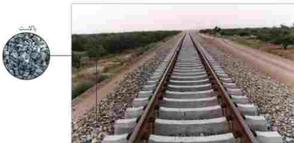
شکل ۴-۱۳ بالاست در ریلپناهن چانه ریل
