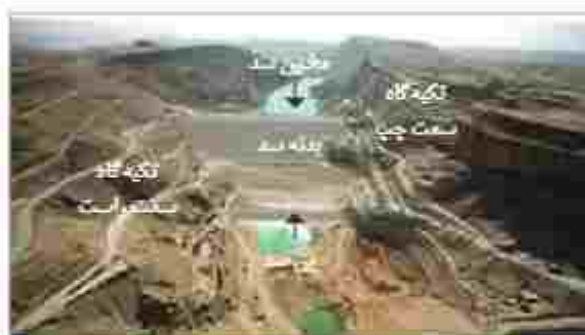
شکل ۴-۴. بعضی از بخش‌های مختلف یک سد
